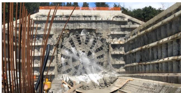
Fig 1 –Testa di una TBM-EPB in azione mentre inietta il prodotto schiumogeno.
